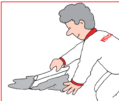
Aluspinnas olevate pragude ning väiksemate aukude katmiseks nii seal, kus kivistunud segu pind võetakse kasutusele pealispinnana kui ka seal, kus pind kaetakse hiljem mõne teise katematerjaliga.
