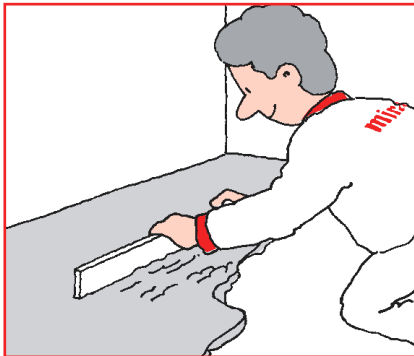
Tasandatakse juhtlatiga. Valmissegatuna on segu töötlemiskõlbulik umbes 30 minutit.
