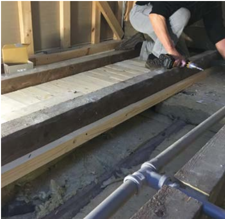
Vahelae taladele kinnitatakse kandeliistud ning paigaldatakse must lagi.
