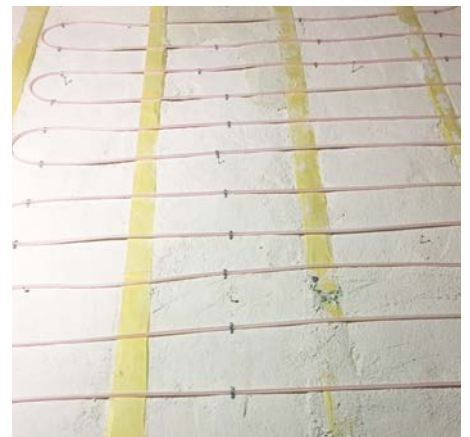
Küte (veetoru või elektrikaabel) kinnitatakse liimpüstoliga või mehaaniliselt kaablisidemetega.
