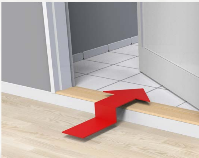
Ehitusplaatidest põrand tekitab märja ruumi uksele künnise, mis on ebamugav ning erivajadustega kasutajale sobimatu.
