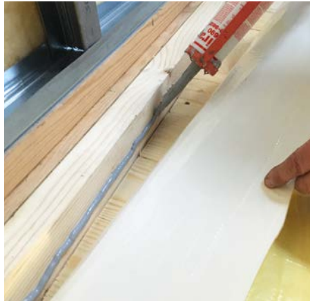
Tala küljele lastakse sammumüramati fikseerimiseks riba 3690 one seal liimi.
