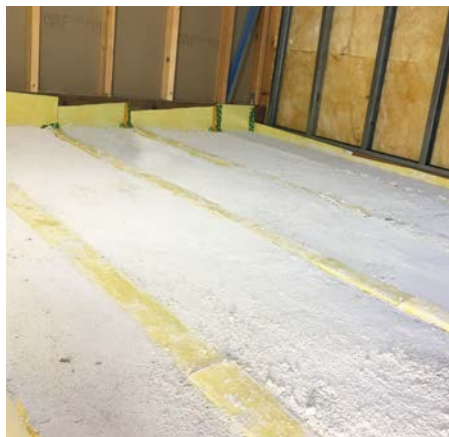
Talade vahe täidetakse ääreni EPS kergbetooniga. Enne armatuurvõrgu ja kütte paigaldust soovitame kergbetooni pind kruntida 4180 krundiga.
