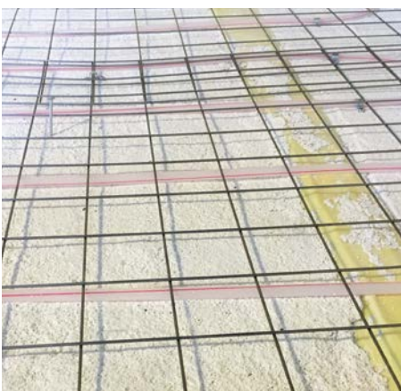
Armatuurvõrk laotatakse kogu põrandapinnale kütdekaablite või -torude peale.
