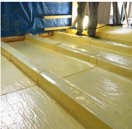
Sammumüra summutusmatt peab olema paigaldatud tihedalt vastu talasid ning musta lage ja pööratud seinale pinnaviimistluse kõrguseni.
