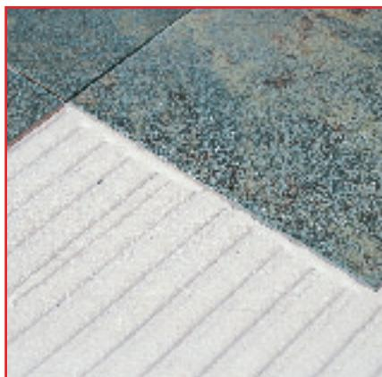
Rievotā līmes kārtā izplūst un izveido kompaktu slāni starp pamatni un flīzi. 3-5 stundas pēc flīžu uzlikšanas var veikt vieglu staigāšanu pa virsmu un šuvju aizpildīšanu.
