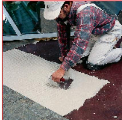
Masa ar robaino špahteli jāizlīdzina pa flīzējamo virsmu tā, lai izveidotos pusapajas rievas līmes kārtā. Materiāla patēriņš ir 4-9 kg/m<sup>2</sup> atkarībā no flīzes lieluma un apakšējās virsmas gluduma. Skat. arī brošūras otru pusi.
